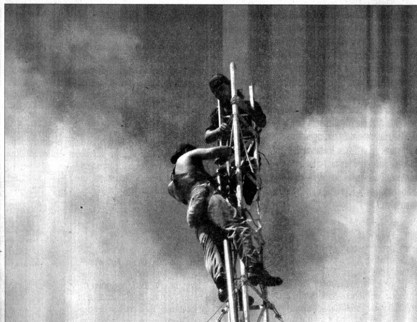
Heffer bei der Installation eines der neuen Sendemasten im Stadtteil La Boca in Buenos Aires
