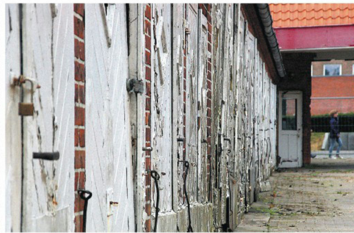
Die alten Garagen sollen zu Ateliers umgebaut werden.
